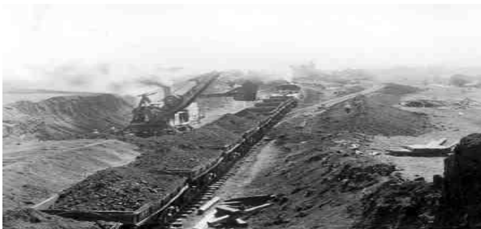
Εικόνα 3. Κατασκευή της διώρυγας
