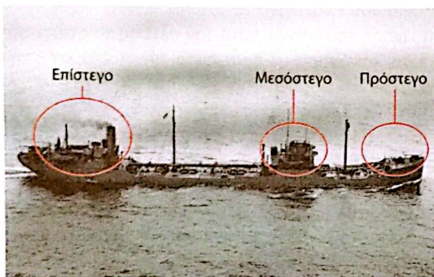
Σχ. 1.3 Πρόστεγο-μεσόστεγο-επίστεγο παλιού δεξαμενόπλοιου T2
