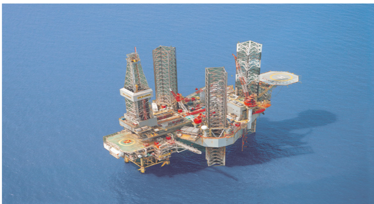
Πυργωτή εγκατάσταση άντλησης πετρελαίου
