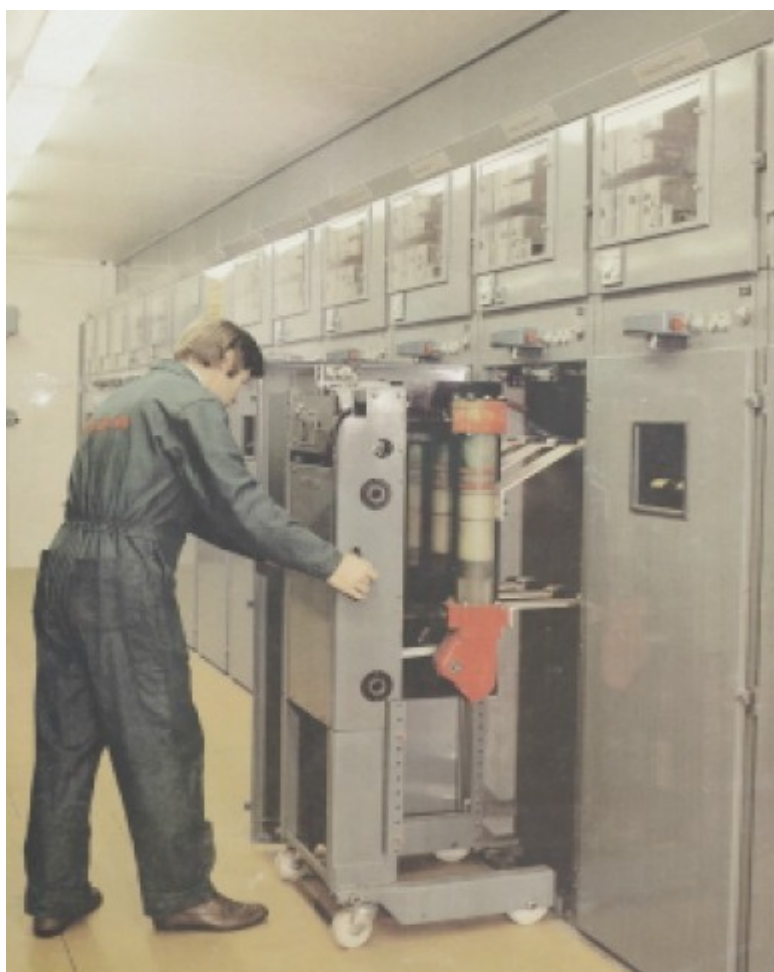
Εικόνα 3.4.2γ.1 Διακόπτης ισχύος επί φορείου.
