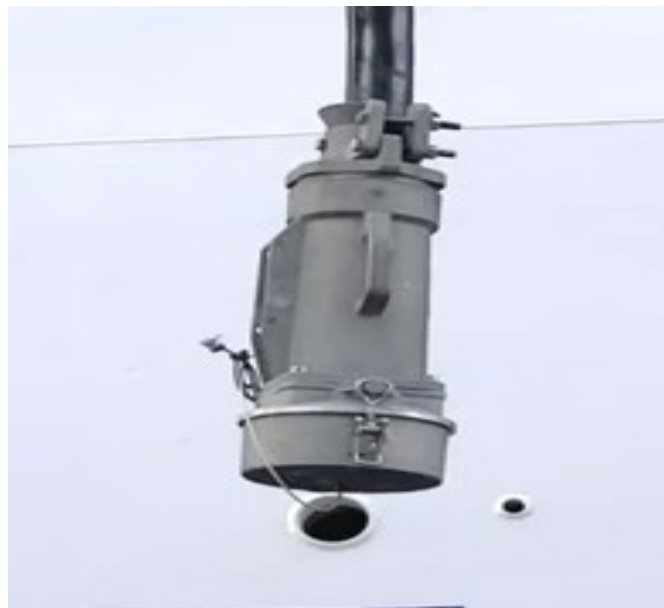
Εικόνα 1.4.2 Καλώδιο μέσης τάσης
