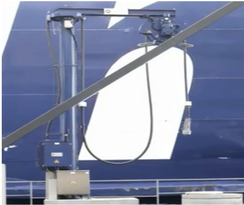
Εικόνα 1.4.1 Γερανός μεταφοράς καλωδίου
