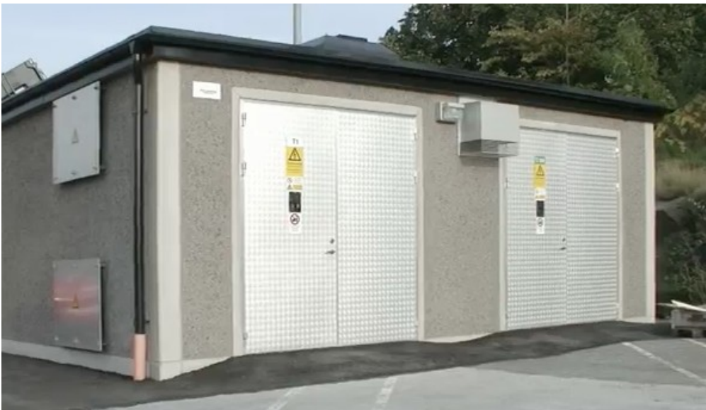
Εικόνα 2.2.1 Επίγειος υποσταθμός
