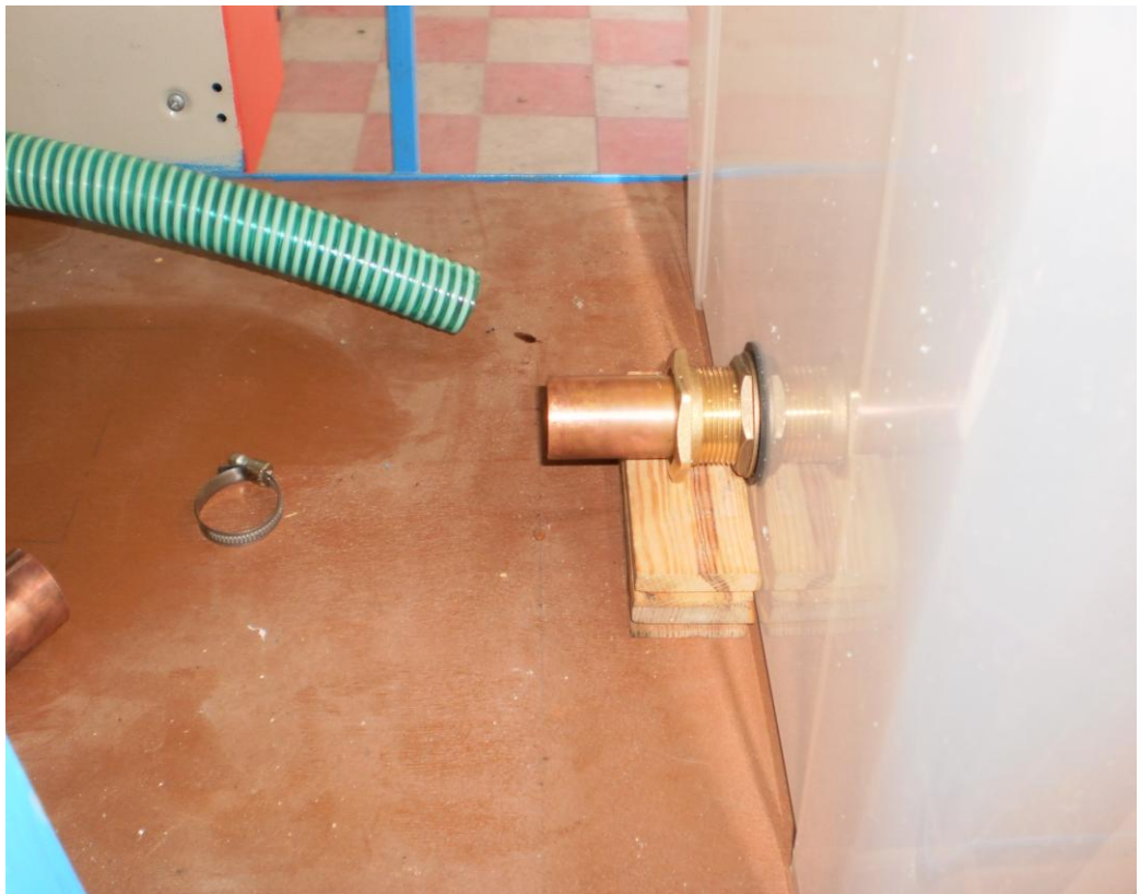
Στεγανοποίησης της δεξαμενής με λαστιχένιους δακτύλιους.
