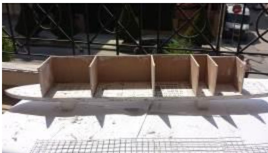
Εικόνα Α.3: Στοκάρισμα και τρίγυμο κατασκευής
