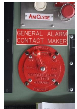
Εικόνα γ: Το σύστημα συναγερμού ασφάλειας του πλοίου
