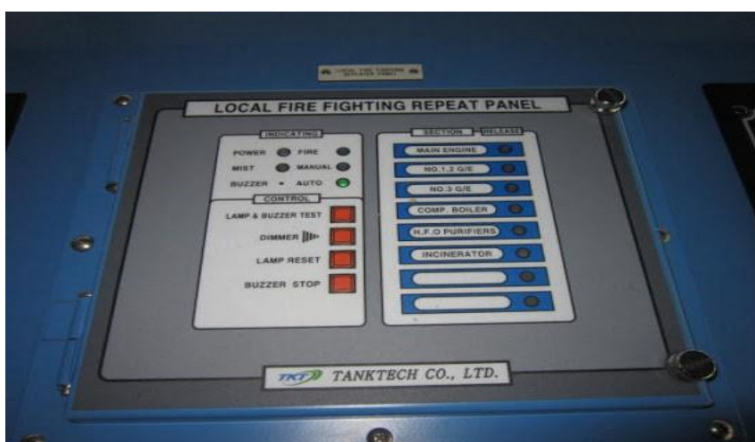
Εικόνα 3.12: Ο συναγερμός πυρκαγιάς του πλοίου.
