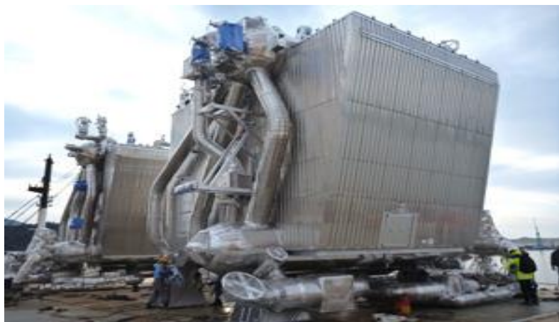
Εικόνα 25 : Λέβητας τύπου D πριν την εγκατάσταση του
