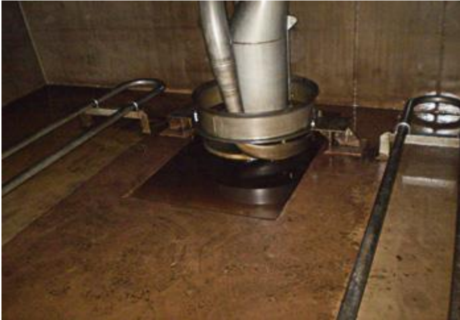
Εικόνα 5) Αντλία εκφορτώσεως τύπου FRAMO
