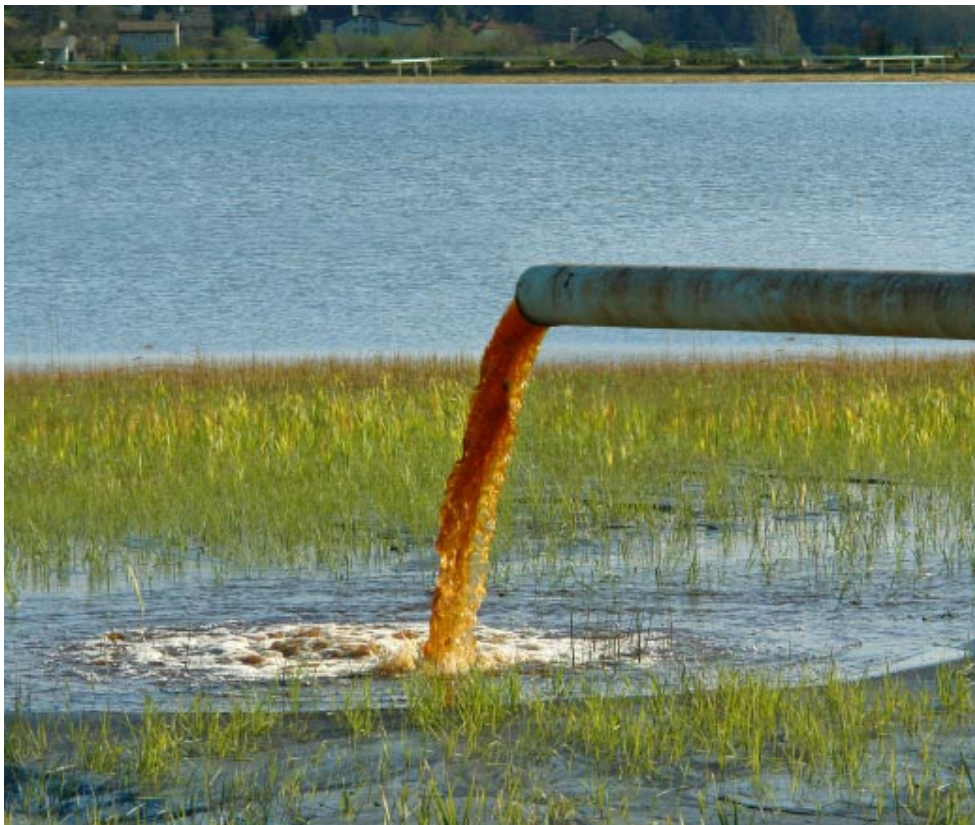
Εικόνα 1. Αγωγός εκβολής σε θαλάσσια νερά.
