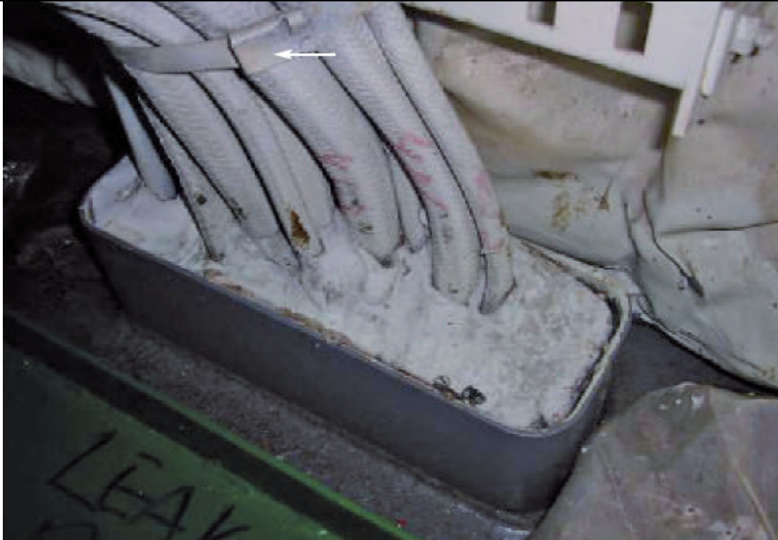
Εικόνα 2-4: Τρύπα καταστρώματος για ηλ. καλώδια
