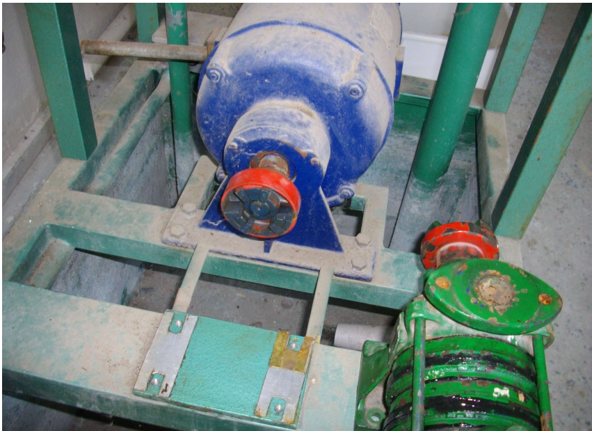
Εικόνα 24: Η αντλία έτοιμη για την επανατοποθέτησή της.
