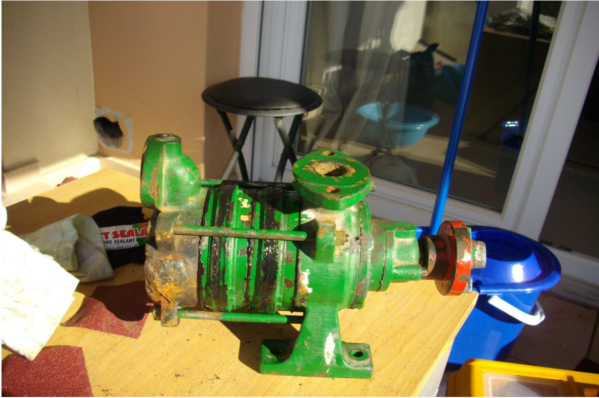
Εικόνα 23: Η αντλία πλήρως επισκευασμένη
