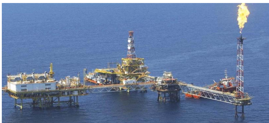
Εικόνα 6. Εγκαταστάσεις εξόρυξης υδρογονανθράκων στην Κυπριακή ΑΟΖ.
