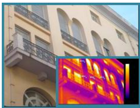
Εικόνα 9. Θερμική προβολή κτιρίου.
