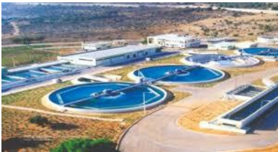
Διυλιστήριο πόσιμου νερού
