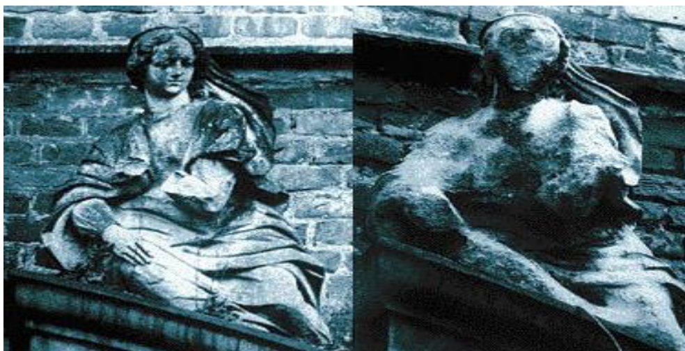
Εικόνα 1.4.1 Γυψοποίηση μνημείου η οποία οφείλεται στην έκθεσή του στην όξινη βροχή.
