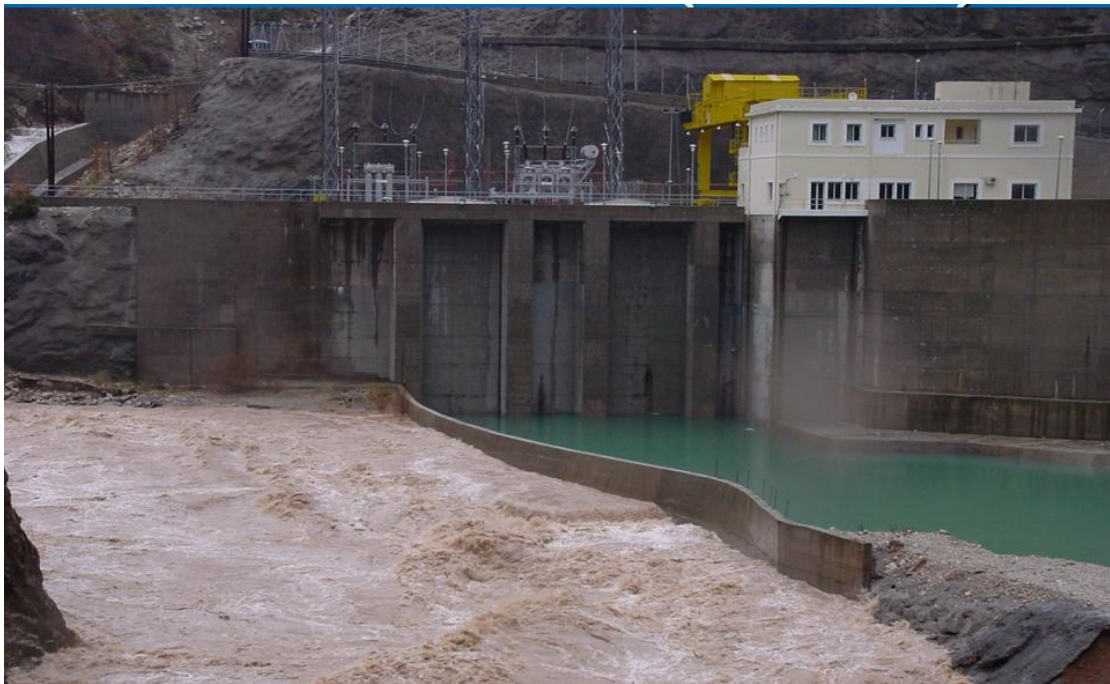
Εικόνα 14: Υδροηλεκτρικός Σταθμός Μεσοχώρας
