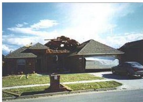
Εικόνα 28- Επίπεδο καταστροφών EF1
