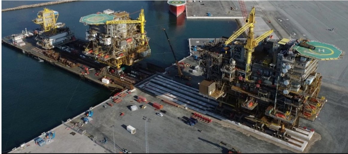
Εικόνα 18: Υπερσύγχρονες εγκαταστάσεις διάλυσης πλοίων στη Δανία Πηγή: www.niras.com
