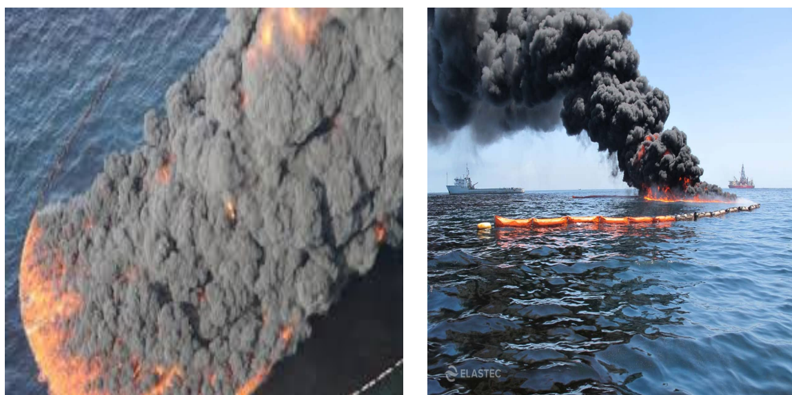
Σχήμα 15. Επί τόπια καύση πετρελαιοκηλίδων [ Πηγή: https://www.linkedin.com/pulse/does-your-offshore-spill-response-plan-include-ala-a-hamdan-pmp , https://www.elastec.com/products/ ]
