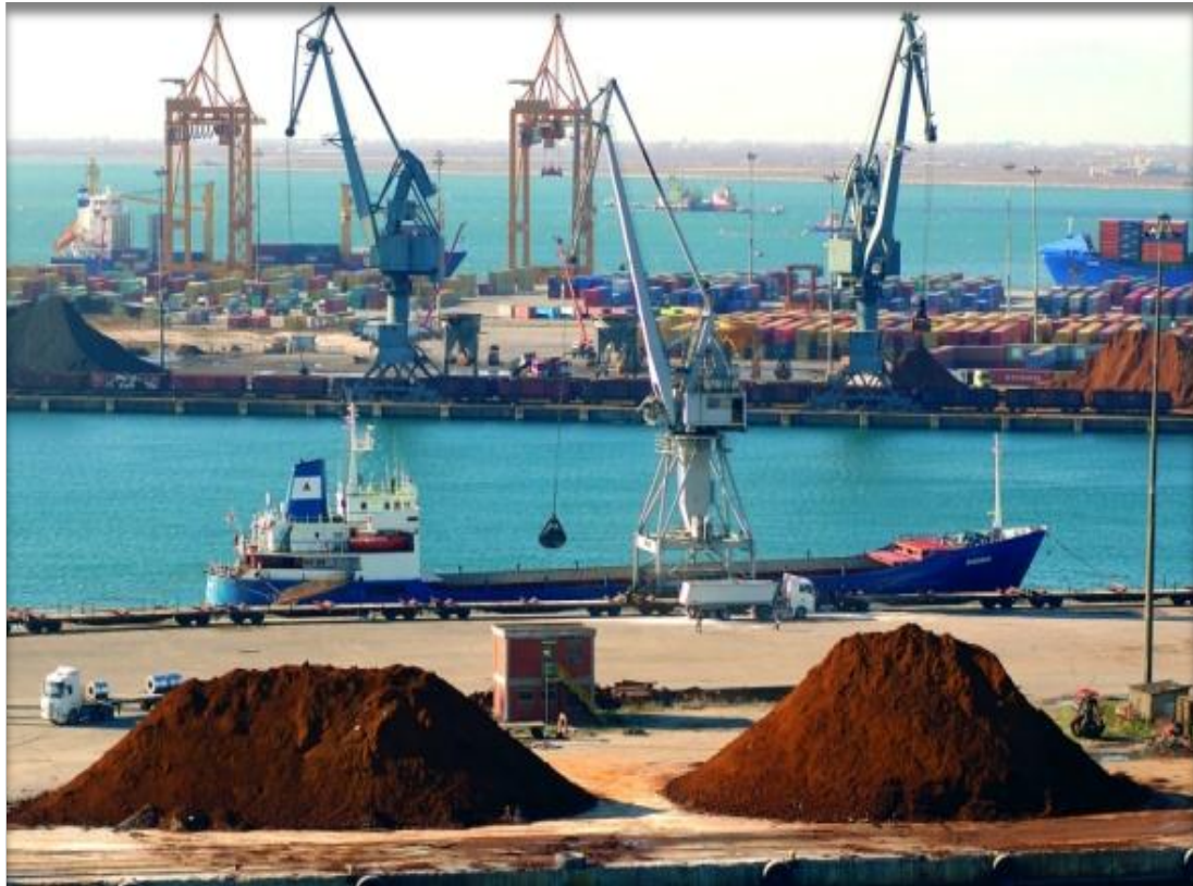
Εικόνα 4: Κρηπίδωμα νούμερο 4 στο λιμάνι της Θεσσαλονίκης.
