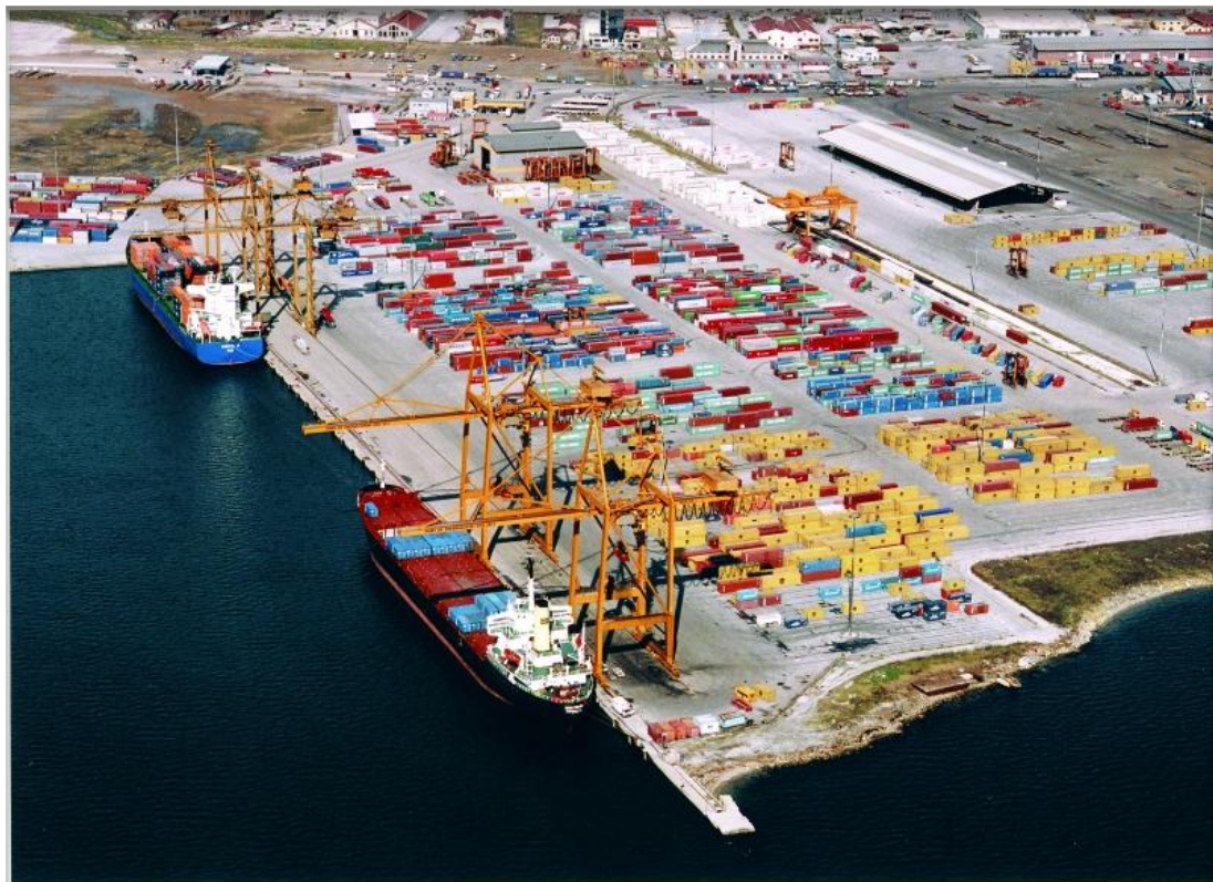
Εικόνα 5: Κρηπίδωμα νούμερο 11 στο λιμάνι της Θεσσαλονίκης.
