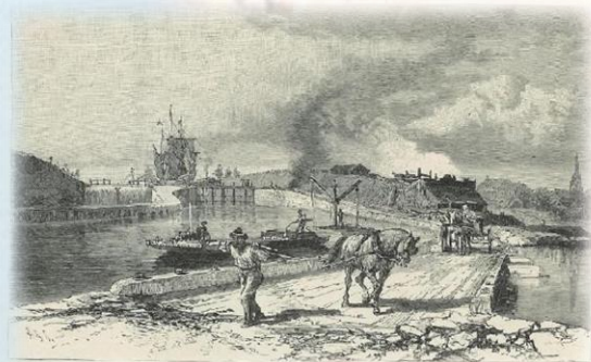
Κατασκευή καναλιού στην λίμνη Οντάριο
