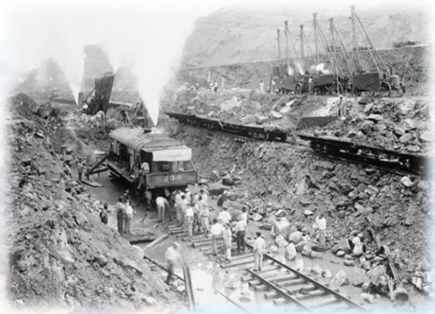
Κατασκευή του καναλιού του Σουέζ
