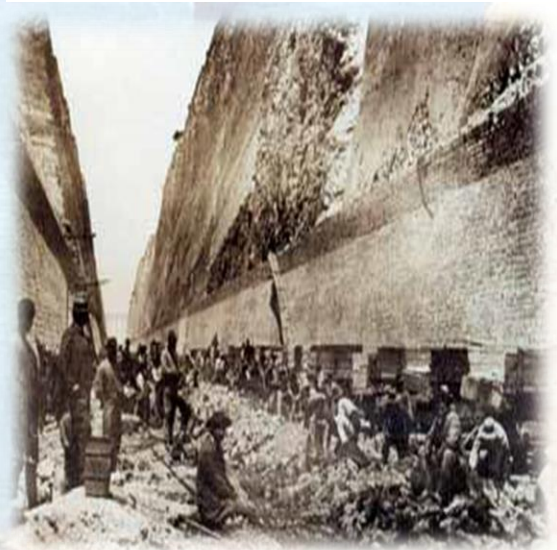
1Διώρυγα της Κορινθου υπο κατασκευή
