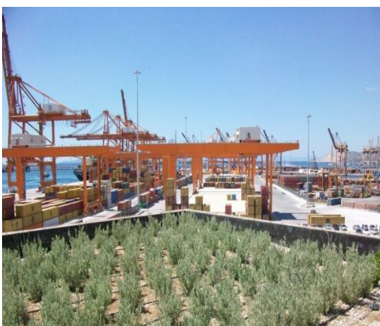
Εικόνα: Η πράσινη ταράτσα του νέου κτιρίου γραφείων στο Νέο Σταθμό Εμπορευματοκιβωτίων (Ν. ΣΕΜΠΟ) ΟΛΠ ΑΕ.
