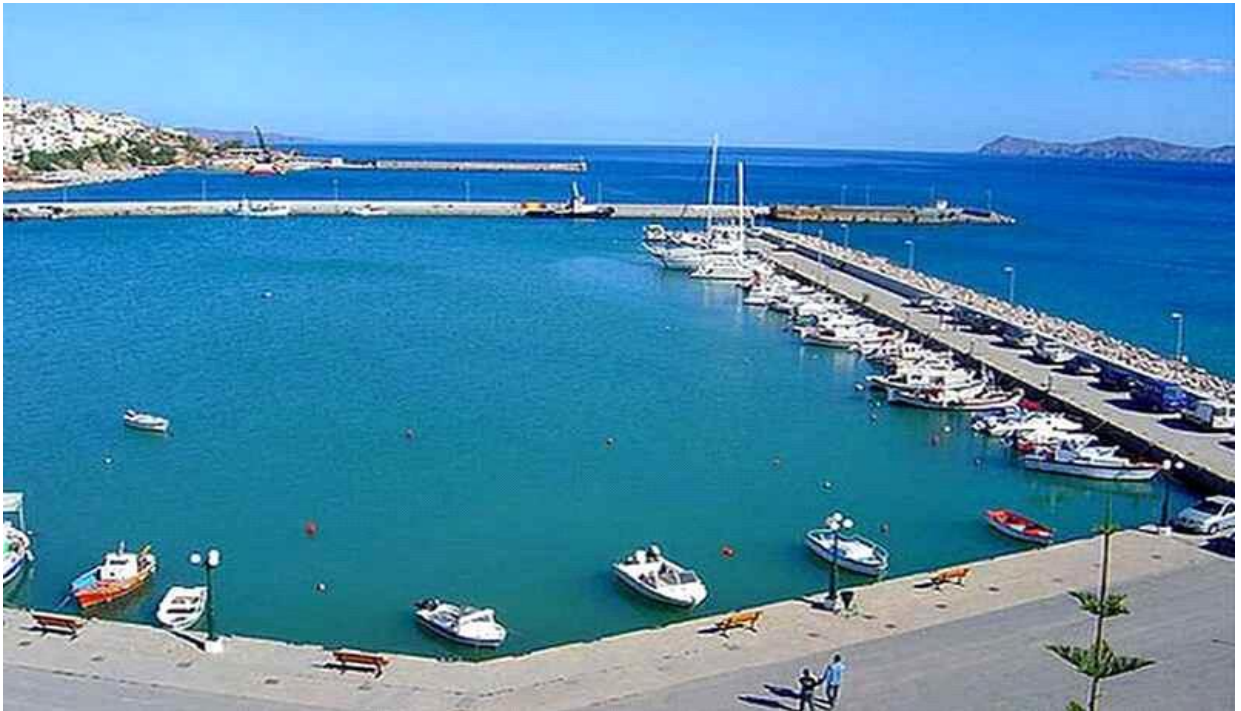
1) Λιμενικές εγκαταστάσεις Σητεία
