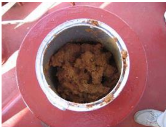
Εικ.3.9: Δοκιμή Can Test
