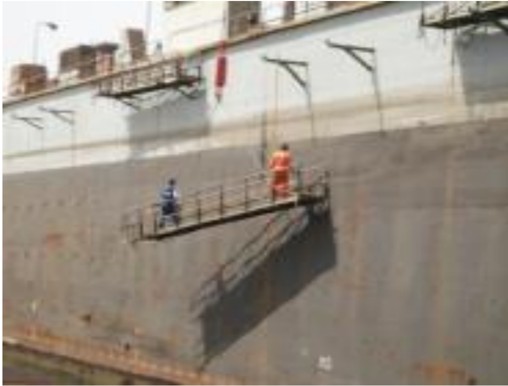
Εικόνα 4. Επισκευή Πλωτής Δεξαμενής
