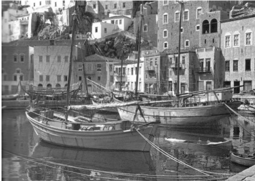
Εικ. 2.1 Λιμάνι της Ύδρας, 1948. Στο βάθος ένα τρεχαντήρι υπό κατασκευή, στο οποίο έχουν τοποθετηθεί οι νομείς και οι φούρμες του. (φωτογρ. Μαλικόπουλος, Μουσείο Μπενάκη)
