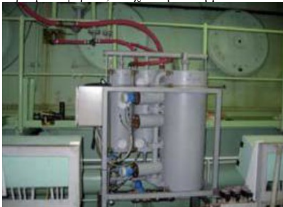
Εικόνα 16: Δεξαμεμές μέτρησης για ψυχρή αποστράγγιση σωλήνων
