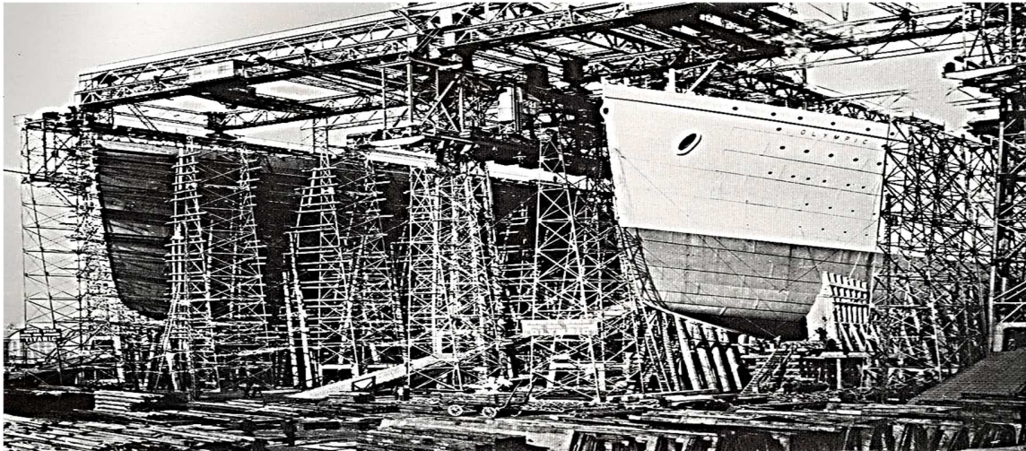
Εικόνα 17 Τα Titanic, Olympic στο στάδιο της κατασκευής τους
