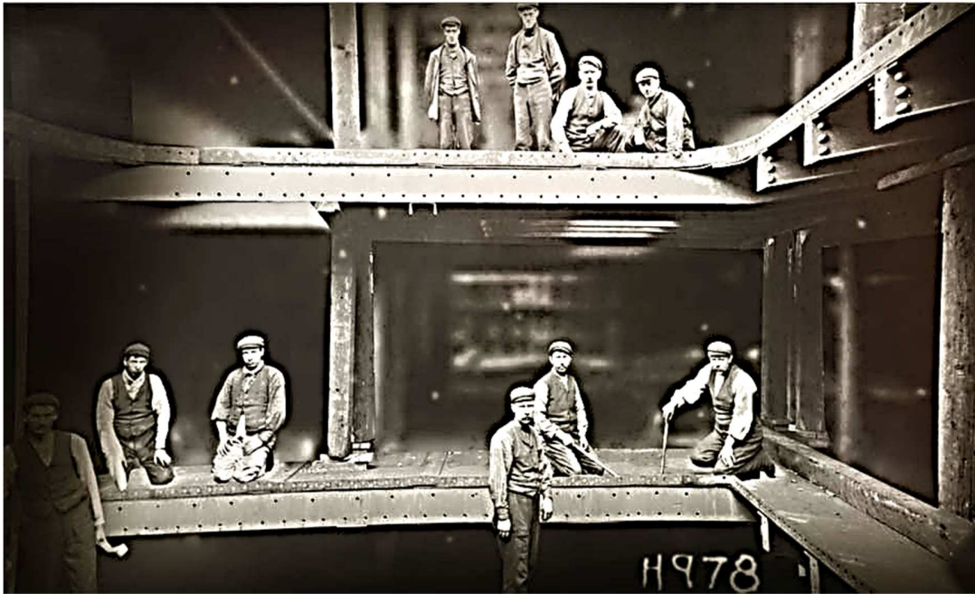
Εικόνα 21 Εργαζόμενοι πάνω στις σιδερένιες δοκούς του πλοίου
