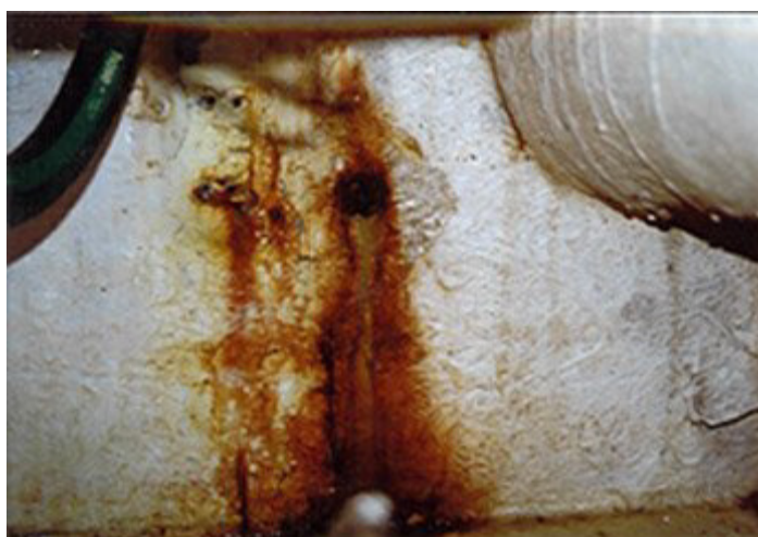
(Εικόνα 7,8) Βακτηριακή διάβρωση
