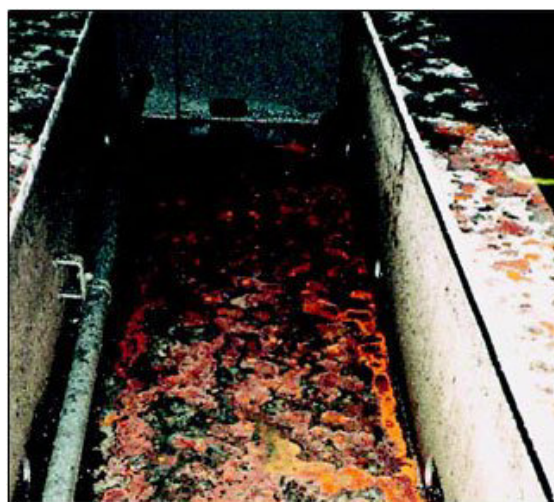
(Εικόνα 7,8) Βακτηριακή διάβρωση
