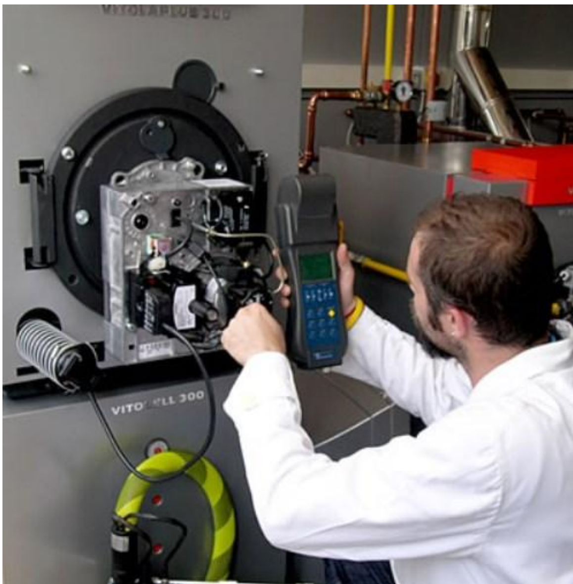
Διαδικασία ελέγχου καυσαερίων με φορητή συσκευή
