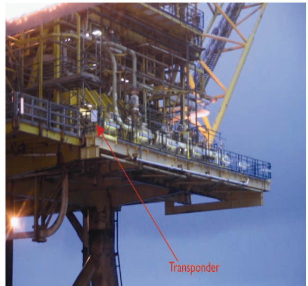
Εικόνα 19: Η θέση του αναμεταδότη στην πλωτή εξέδρα
