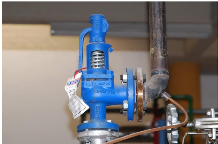
Εικόνα 4.1 Βαλβίδα εκτόνωσης πίεσης (Pressure Relief Valve)
