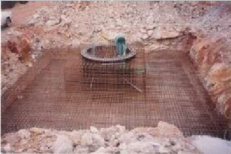
Θεμελίωση πύργου
