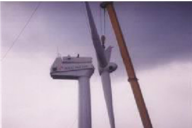
Τοποθέτηση μηχανής και έλικα
