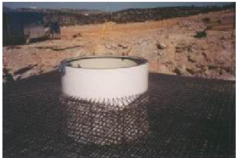
Θεμελίωση πύργου
