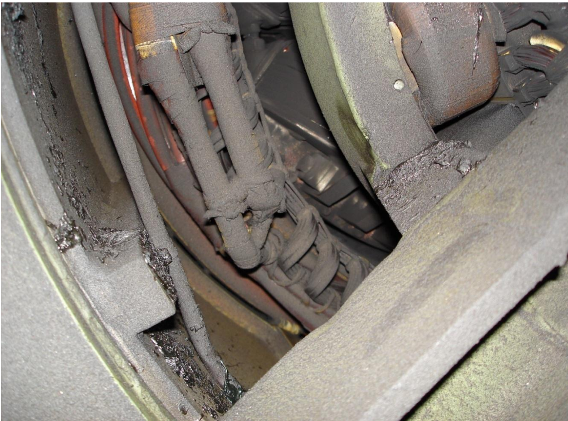
Εικόνα 1.3: Γεννήτρια με εναποθέσεις άνθρακα
