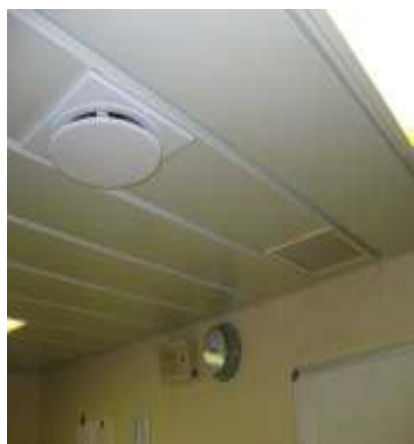
Εικόνα 2.1 Θολωτός διαχύτης αέρα
