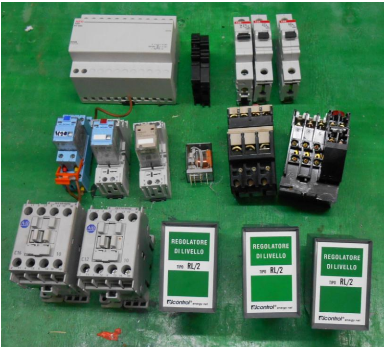
ΕΙΚΟΝΑ 3.18: ΗΛΕΚΤΡΟΛΟΓΙΚΟ ΥΛΙΚΟ (ΜΕΤΑΣΧΗΜΑΤΙΣΤΗΣ, ΑΣΦΑΛΕΙΕΣ, ΡΕΛΕ, ΘΕΡΜΙΚΑ, ΕΛΕΓΚΤΕΣ ΑΙΣΘΗΤΗΡΙΩΝ ΣΤΑΘΜΗΣ)
