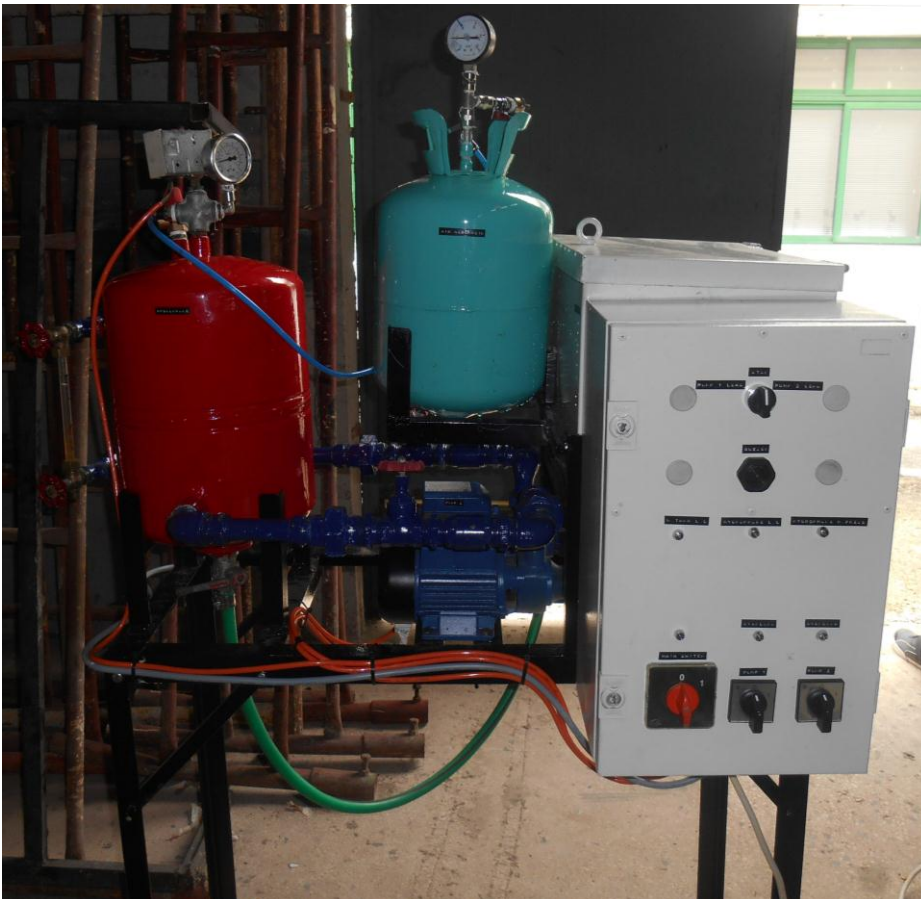
ΕΙΚΟΝΑ 3.20: Η ΚΑΤΑΣΚΕΥΗ ΟΛΟΚΛΗΡΩΜΕΝΗ
