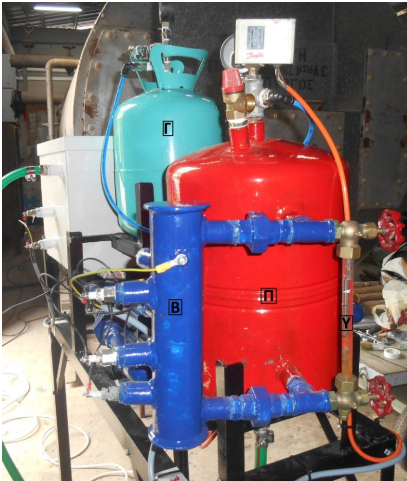
ΕΙΚΟΝΑ 3.3: ΑΡΙΣΤΕΡΗ ΠΛΑΓΙΑ ΟΨΗ ΚΑΤΑΣΚΕΥΗΣ
