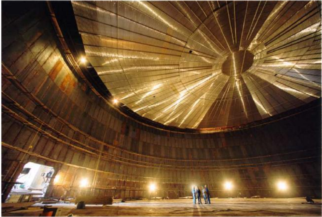
Εικόνα 9. Εσωτερικό Δεξαμενής LNG.
