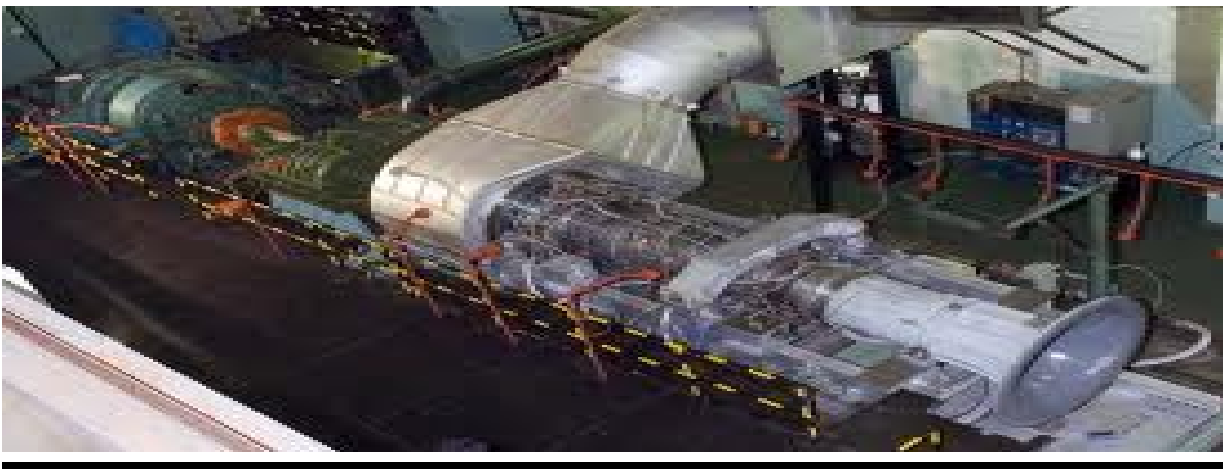
Εικόνα 1.3.7. Αεριοστρόβιλος σε πλήρη εγκατάσταση στο πλοίο.
