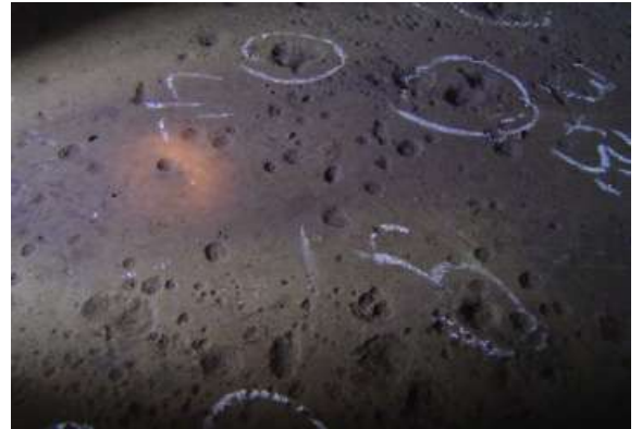
Σχ 10. Διάβρωση (pitting) πυθμένα χαλύβδινης δεξαμενής καυσίμου οφειλόμενη σε SRB (Πηγή: ECHA Microbiology Ltd.)
