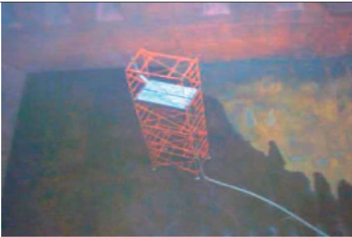
Εικόνα 1-4:Η σκαλωσιά που χρησιμοποιήθηκε κατά το πλύσιμο στο αμπάρι (cargo hold).
