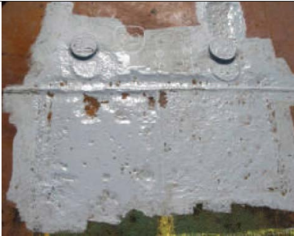
Εικόνα 4-2: Διάβρωση
