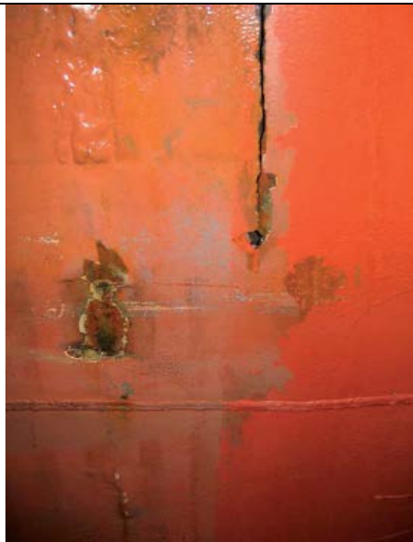
Εικόνα 4-11: Ρωγμή στην πλευρά του πλοίου
