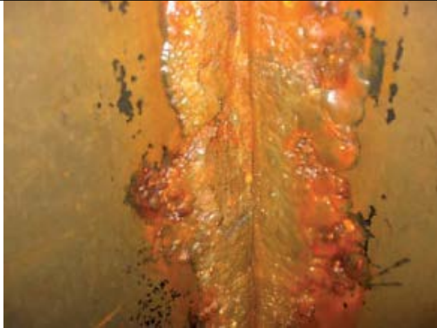
Εικόνα 4-10: Διάβρωση (grooving corrosion) στη πλευρά του πλοίου Κρυμμένη πίσω από επιστρώσεις
