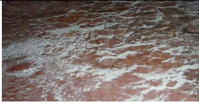
Εικόνα 4-13: Σκασμένα (pitted) πλευρικά ελάσματα πίσω από το κάλυμμα
