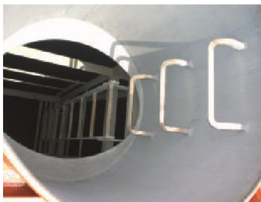
Εικ.4.2.1: Είσοδος στη δεξαμενή
