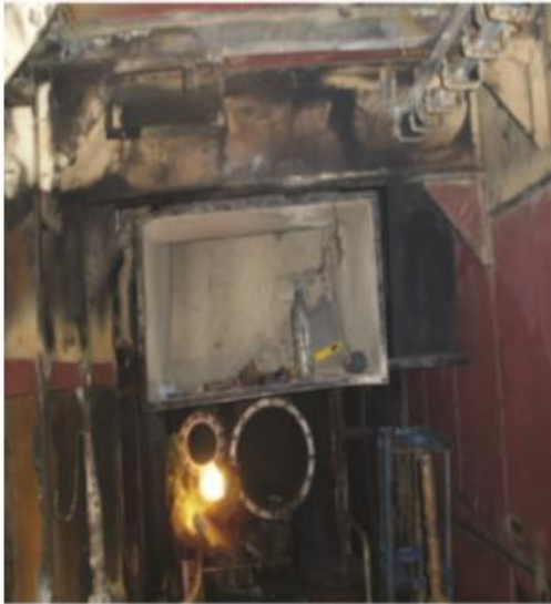
Εικ.2.3.1 και 2.3.2: Ζημιές μετά από την πυρκαγιά στο μηχανοστάσιο. Η πυρκαγιά προκάλεσε ζημιές σε μηχανισμούς, σωλήνες, καλώδια και φρακτές.
