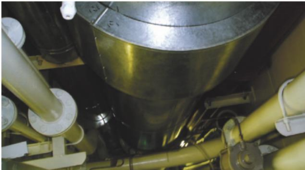
Εικ.2.3.5 παράδειγμα ικανοποιητικής μόνωσης μιας φλάντζας
