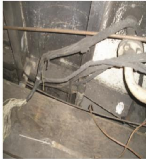
Εικ.2.3.1 και 2.3.2: Ζημιές μετά από την πυρκαγιά στο μηχανοστάσιο. Η πυρκαγιά προκάλεσε ζημιές σε μηχανισμούς, σωλήνες, καλώδια και φρακτές.
