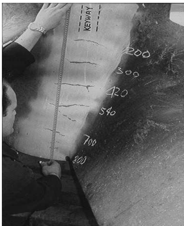
Εικόνα. Ρωγμές στην έλικα
