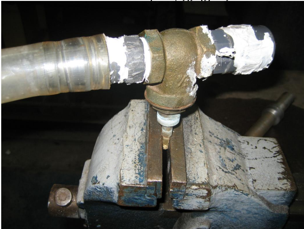
Εικόνα 3.22 Η μια από τις τρεις βάνες σε φάση επισκευής
