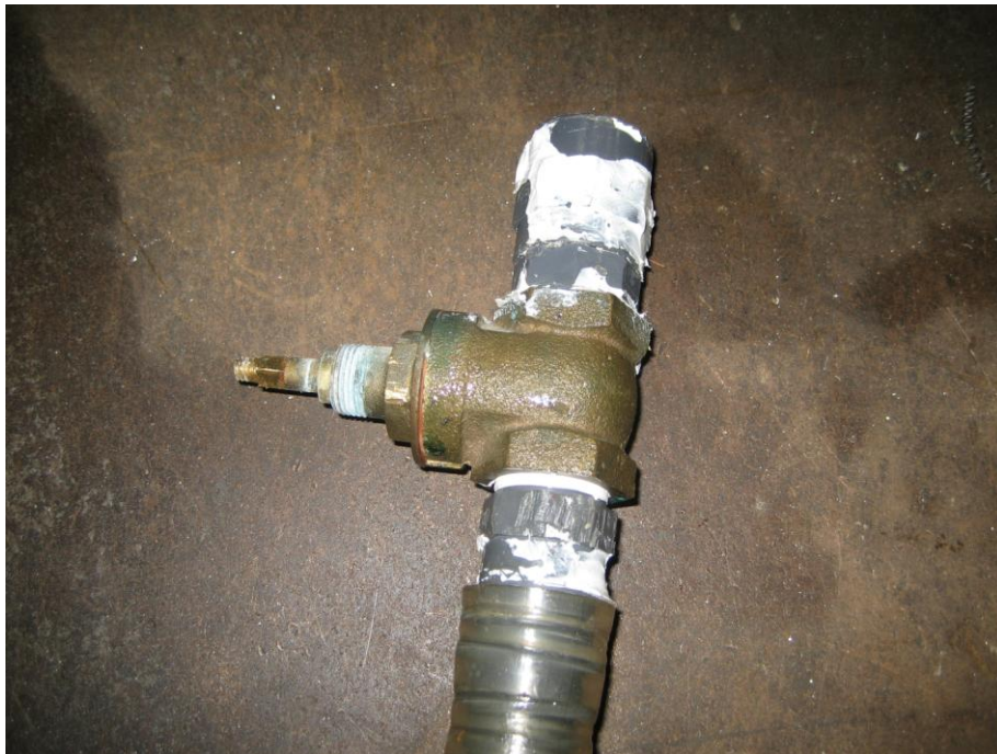
Εικόνα 3.20 Η μια από τις τρεις βάνες πριν την επισκευή
