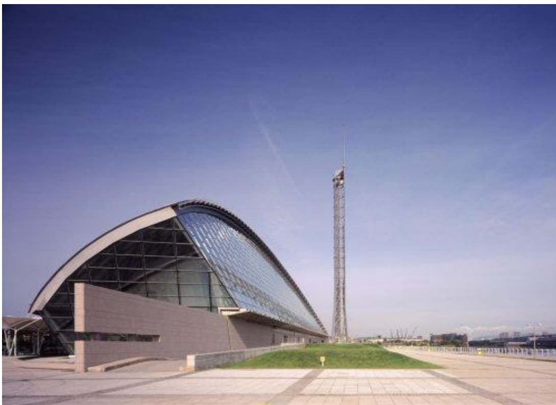
Εικόνα 1.9: Η μελέτη της ροής του αέρα σε κτίρια με μη συμβατικά σχέδια είναι σημαντική για την αποφυγή υψηλών ταλαντώσεων
