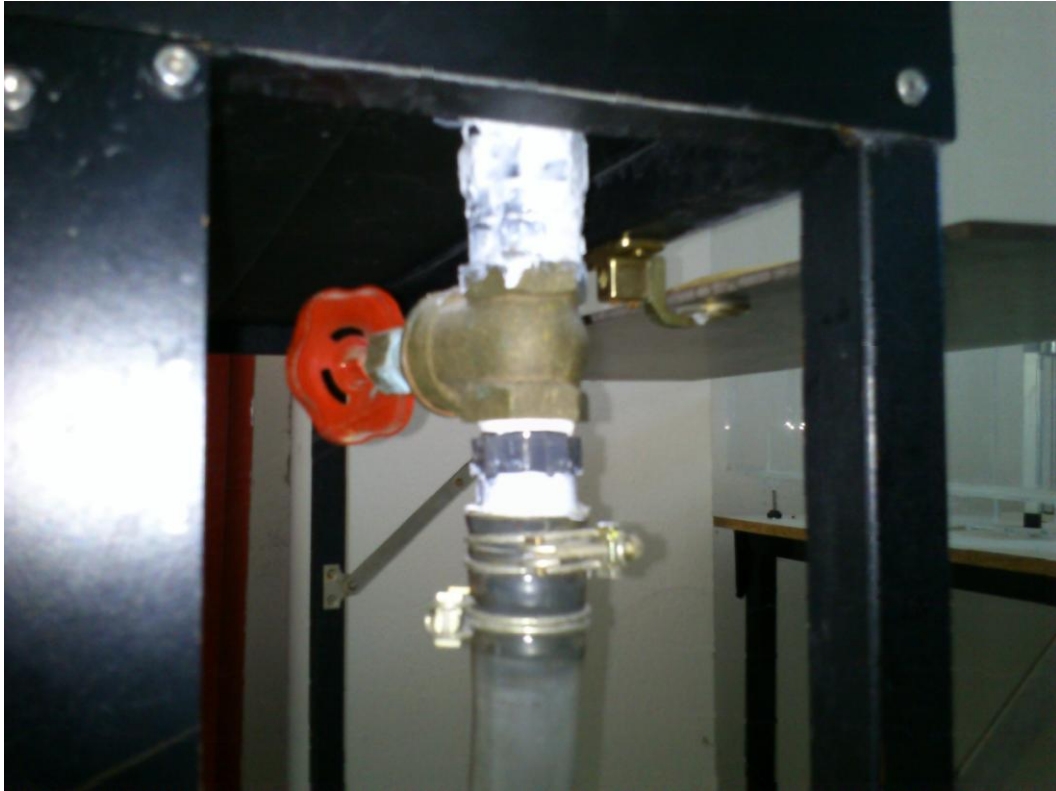
Εικόνα 3.2 Οι βάνες και οι πλαστικές σωληνώσεις επισκευασμένες επίσης με σιλικόνη
