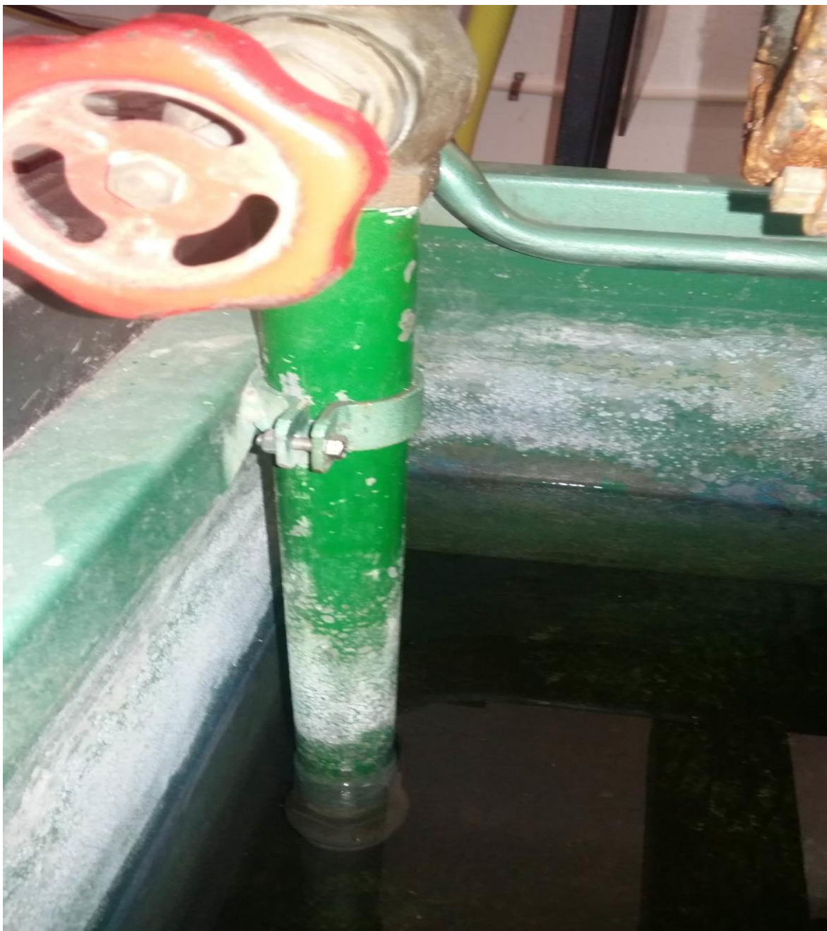
Εικόνα 2.1.4α: Σωλήνα αναρρόφησης μαζί με βαλβίδα αναρρόφησης
