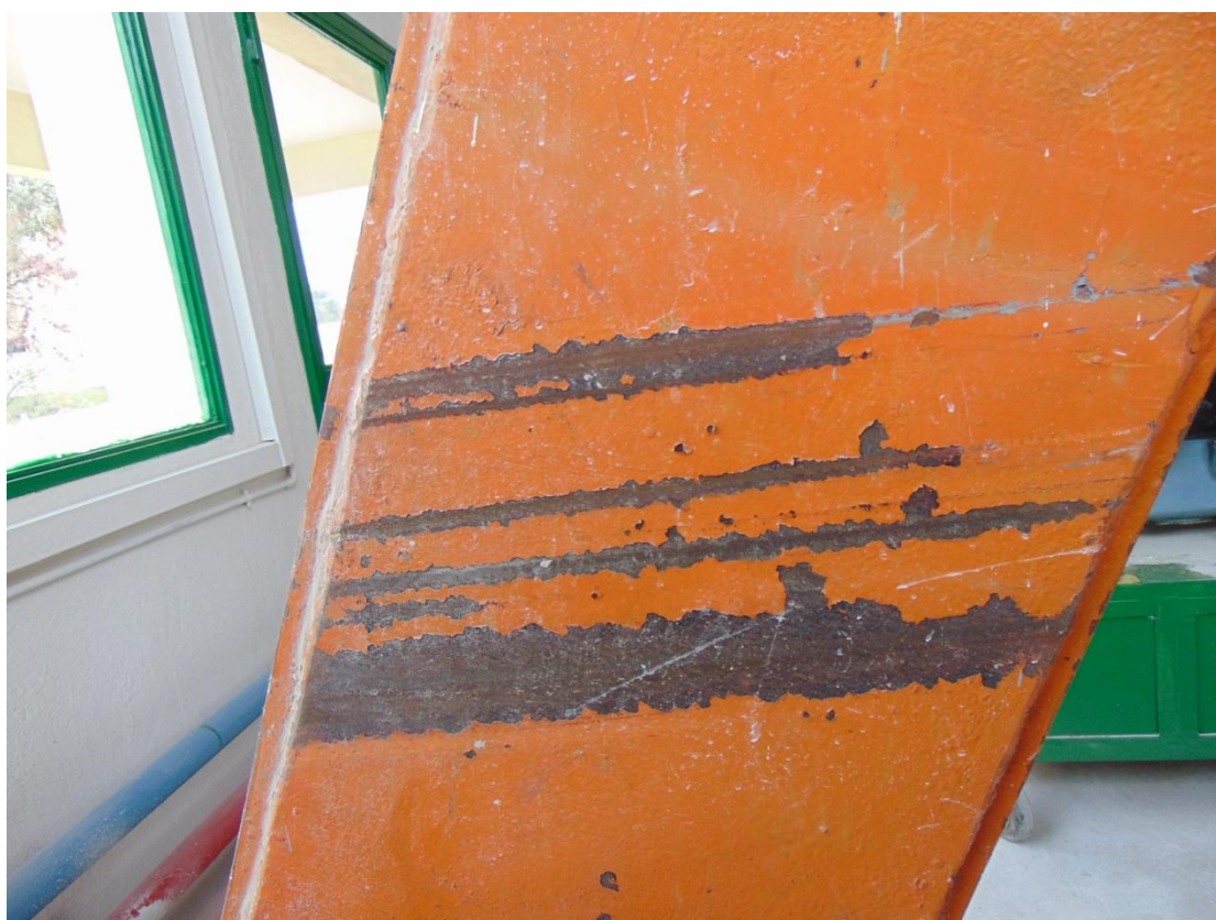
Εικόνα 36 Εκδορές στην πίσω αριστερή πλευρά οι οποίες προκλήθηκαν από επαφή της μεταλλικής επιφάνειας με τον τοίχο του μηχανουργείου.
