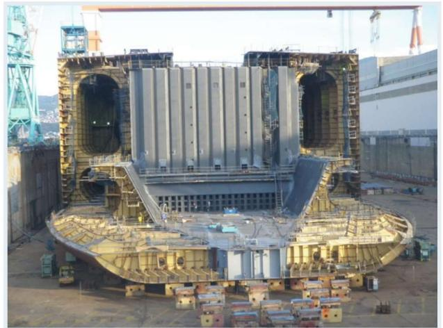
στην διπλανή εικόνα απεικονίζεται κατασκευή πλοίου
