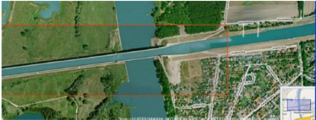
Εικόνα 1: Υδάτινη γέφυρα Magdeburg-Γερμανία. Μήκος: 1km, Πλάτος: 32m
