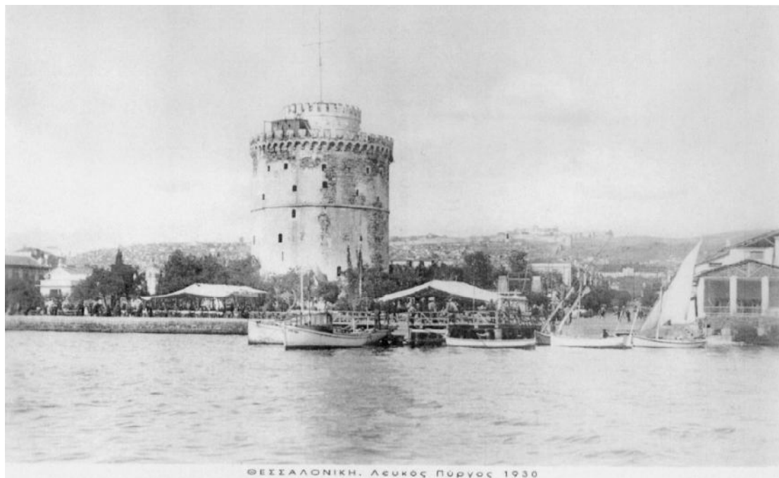
Εγκατάσταση επιβίβασης/αποβίβασης κοντά στον Λευκό Πύργο ( Χρονολογία : περίπου 1930 )
