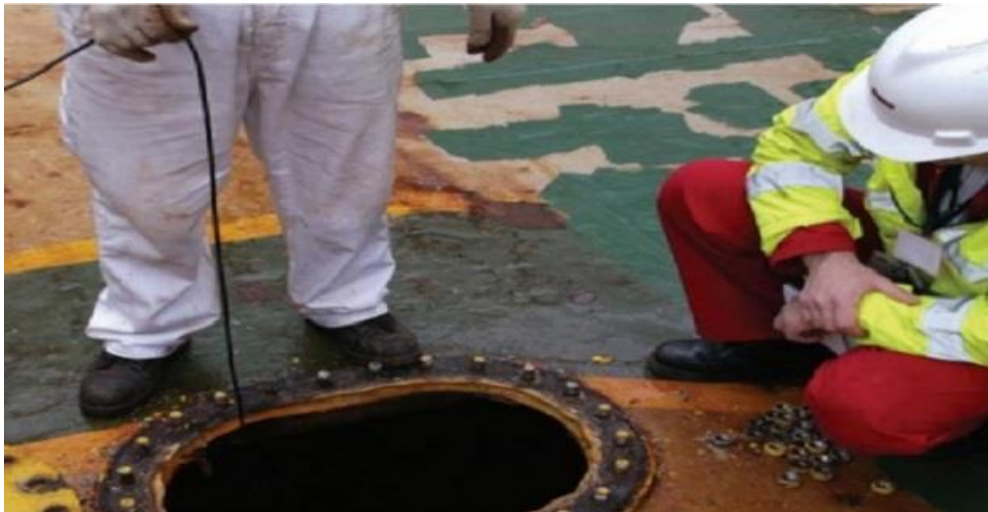
Εικόνα 25. Μέτρηση οξυγόνου πριν την είσοδο ναυτικών σε κλειστό χώρο
