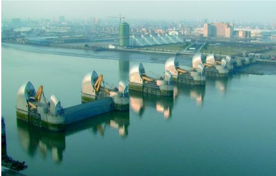
Εικόνα 9: Φράγμα στον ποταμό Τάμεση στο Λονδίνο
