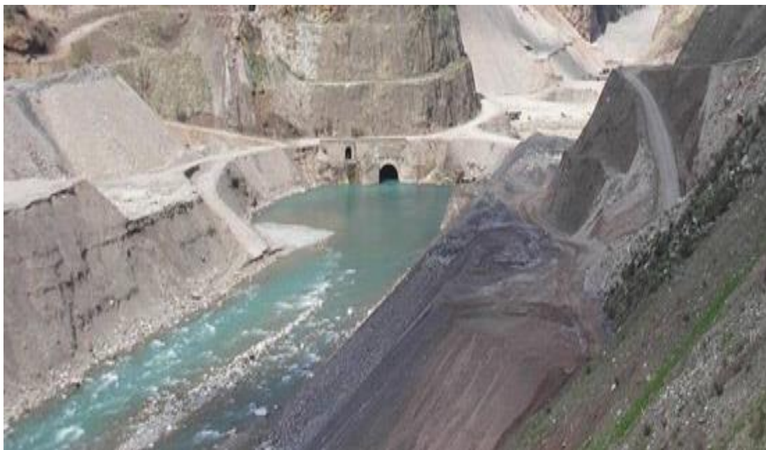
Εικόνα 10: Διαδικασία εκτροπής ποταμού για θωράκιση έναντι πλημμυρικού κινδύνου
