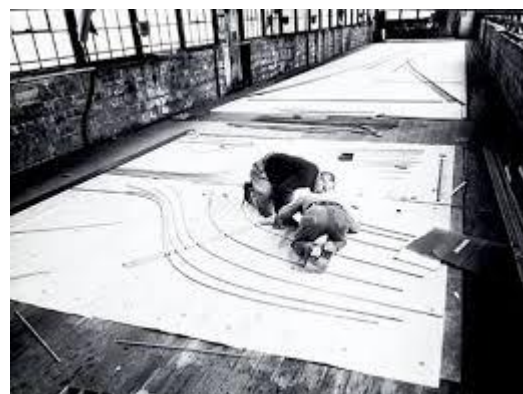
Εικόνα 62: Ναυπηγικό μοντέλο κατασκευασμένο με τη μέθοδο του μισομόδελου.
