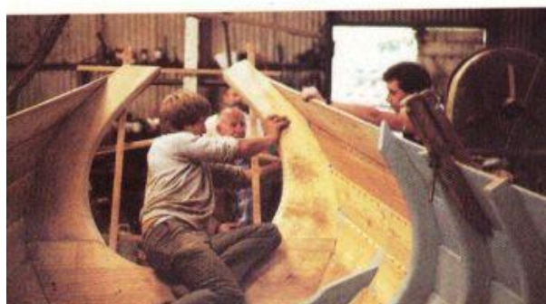
Εικόνα 79: Κατασκευή Σκάφους με τη Μέθοδο ColdMoulding
